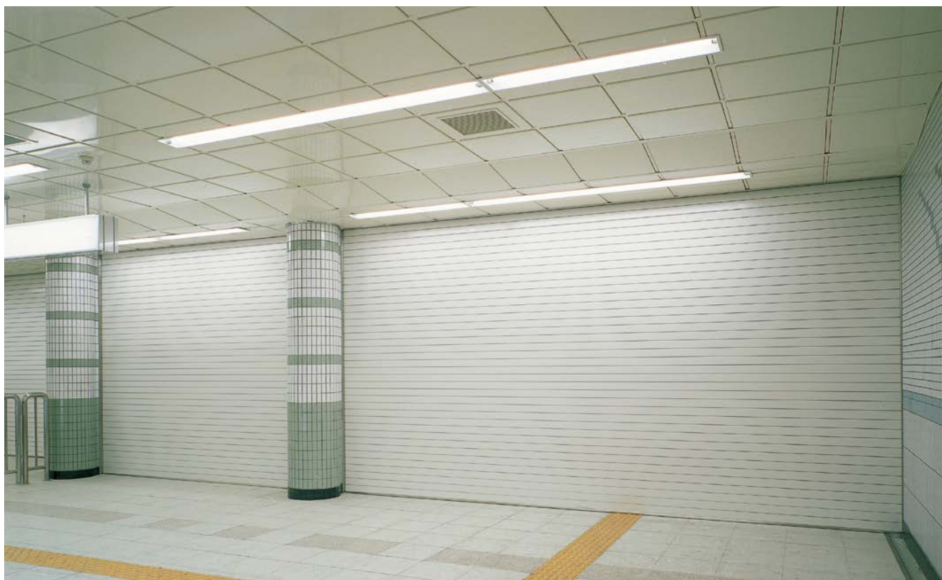
●防煙防火シャッター
