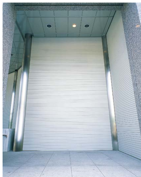
●防火シャッター
